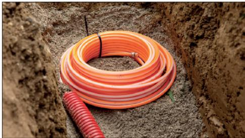
Abb. 1: aufgerollter Bund Glasfaser-Mikrorohr
